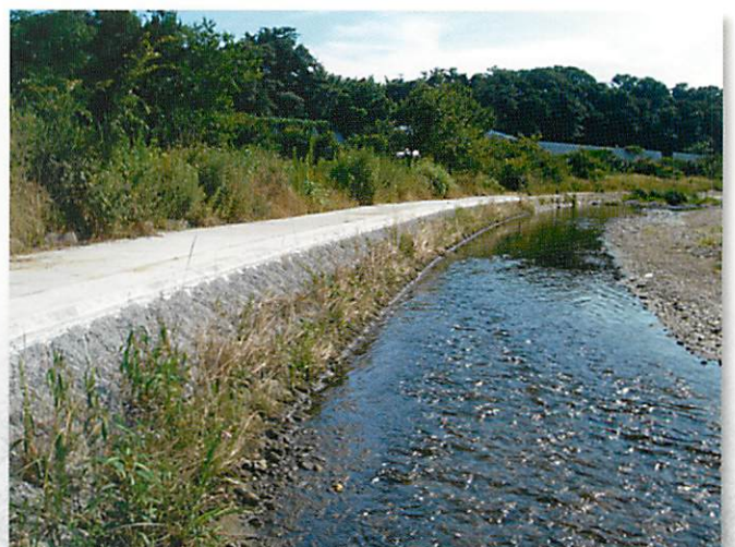
(施工後1年2ヶ月経過)
