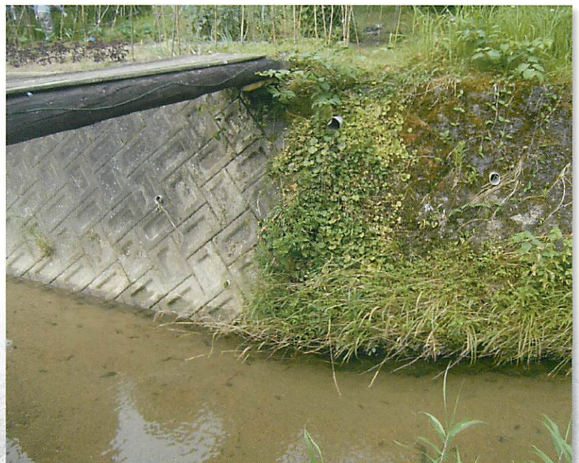
既設護岸との取付部の状況
